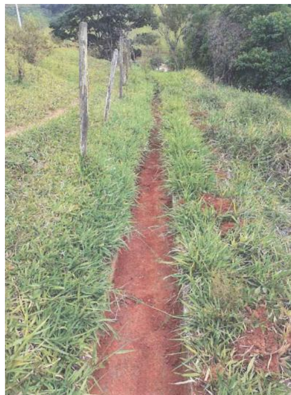
Figura 4.17 Rota 116 – Limpeza de drenagem– km 104 a 111
