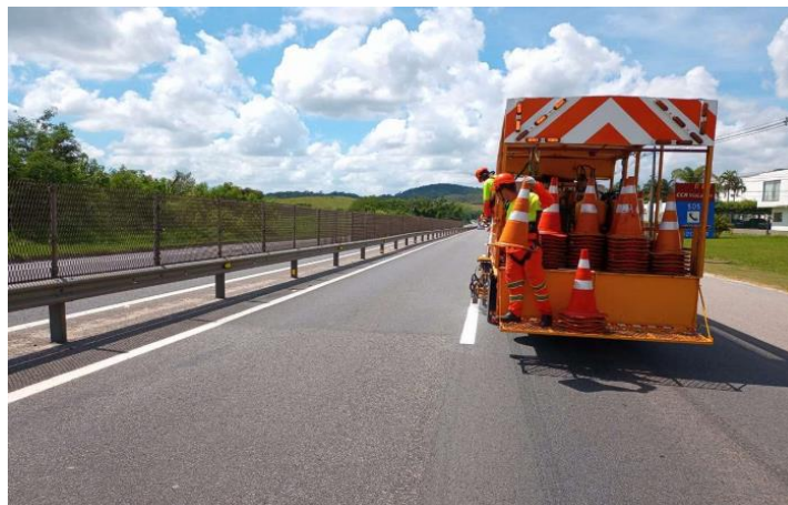
Figura 4.4 Via Lagos - Pintura de Faixas - Km 3+500 Norte
