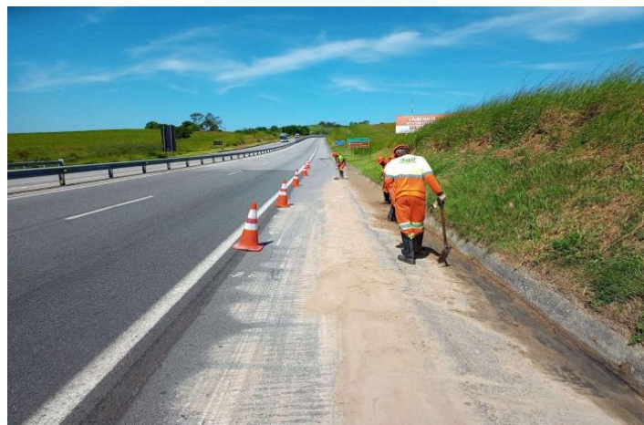
Figura 4.7 Via Lagos - Limpeza de Sarjeta - Km 45+400 Norte
