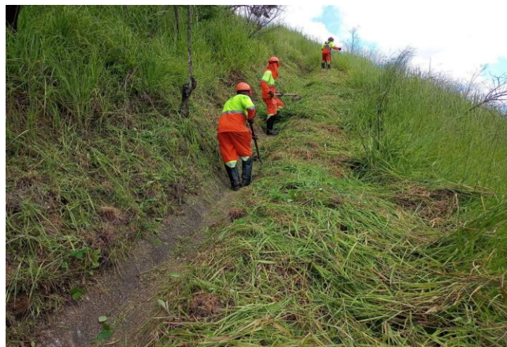
Figura 4.6 Via Lagos - Limpeza de Canaleta - Km 2+500 Norte
