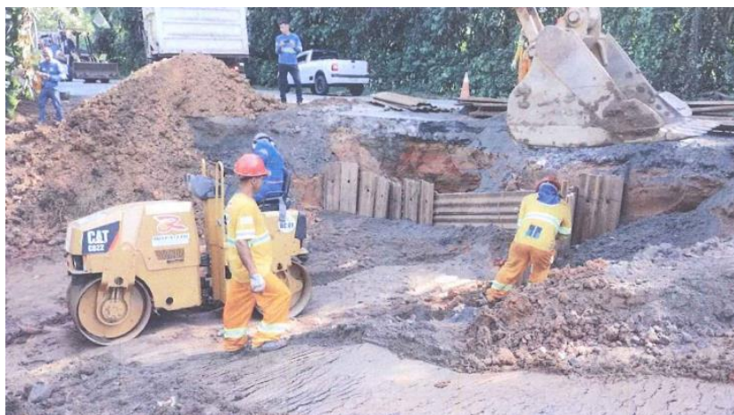
Figura 4.15 Rota 116 – Restauração de Drenagem– Km 35.5
