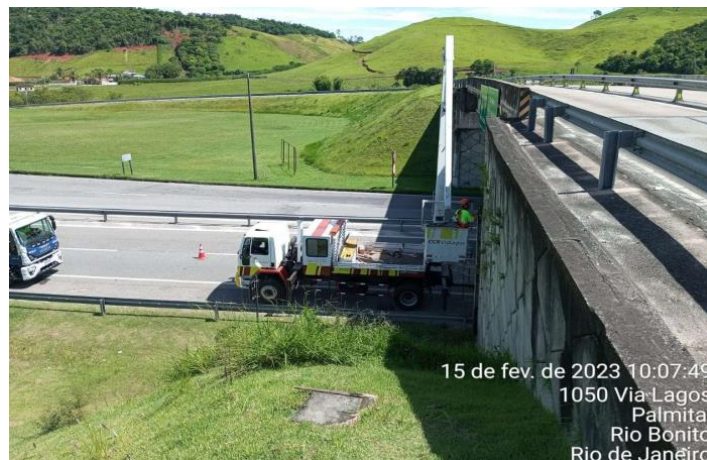
Figura 4.8 Via Lagos - Limpeza de Viaduto - Km 21+500 Norte
