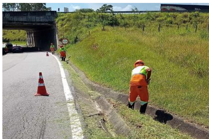
Figura 4.10 Via Lagos - Roçada Manual - Km 30+000 Sul
