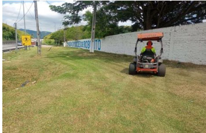
Figura 4.11 Via Lagos - Roçada Mecânica - Km 9+300 Norte
