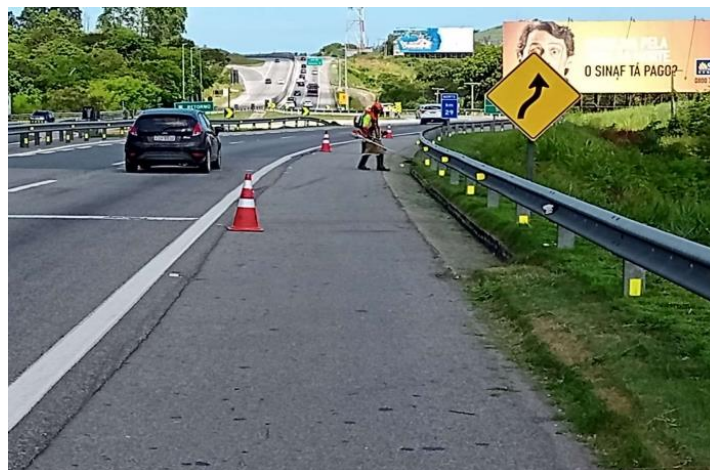
Figura 4.9 Via Lagos - Roçada Manual - Km 29+000 Norte
