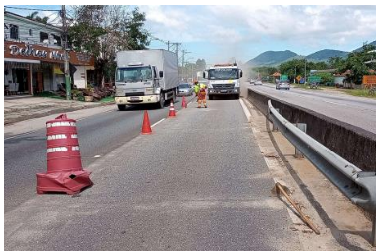
Figura 4.13 Via Lagos - Varrição de Mediana - Km 13+000 Norte
