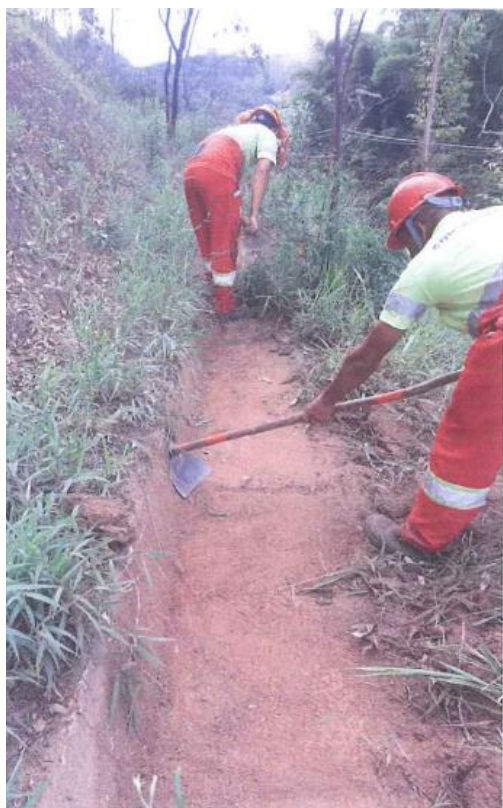
Figura 4.16 Rota 116 – Limpeza de drenagem – Km 91 a 101
